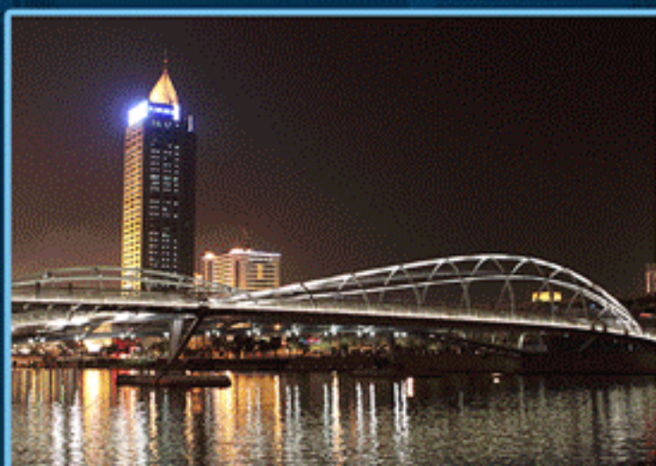
金阜桥：翠袖当空 JINFU BRIDGE
